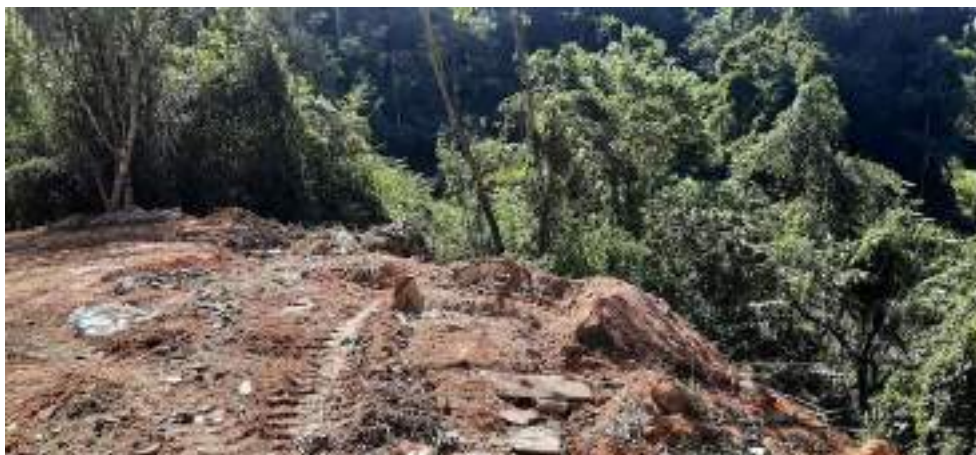
Figura 53: Área utilizada como destino de resíduos da limpeza pública de capina/roçada – Parte 2.
