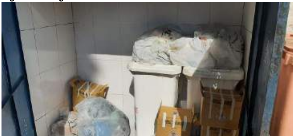
Figura 67: Abrigo externo de RSS da Unidade Mista de Saúde – Vista Interna.
