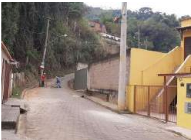
Figura 49: Serviço de Capina sendo finalizado.
