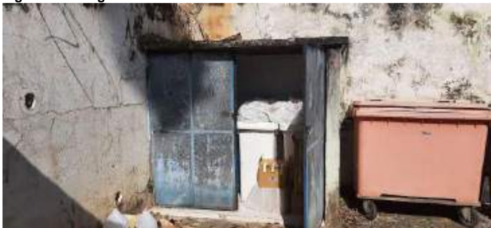
Figura 66: Abrigo externo de RSS da Unidade Mista de Saúde – Vista externa.
